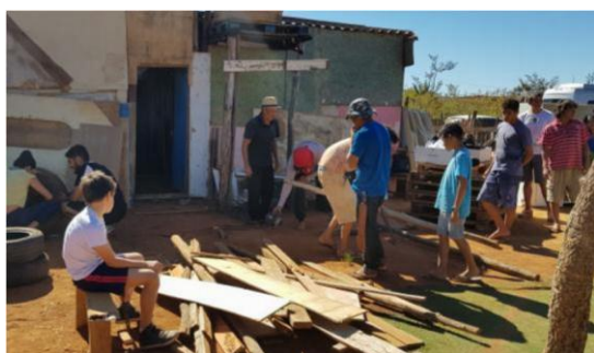
Foto 1 - Mutirão de limpeza do espaço no acampamento Marias da Terra
